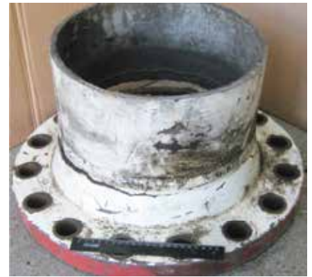
Фото 3. Фрагмент поступившей на экспертизу трубы \varnothing 325 \times 8 \approx 200 мм с приваренным фланцем
